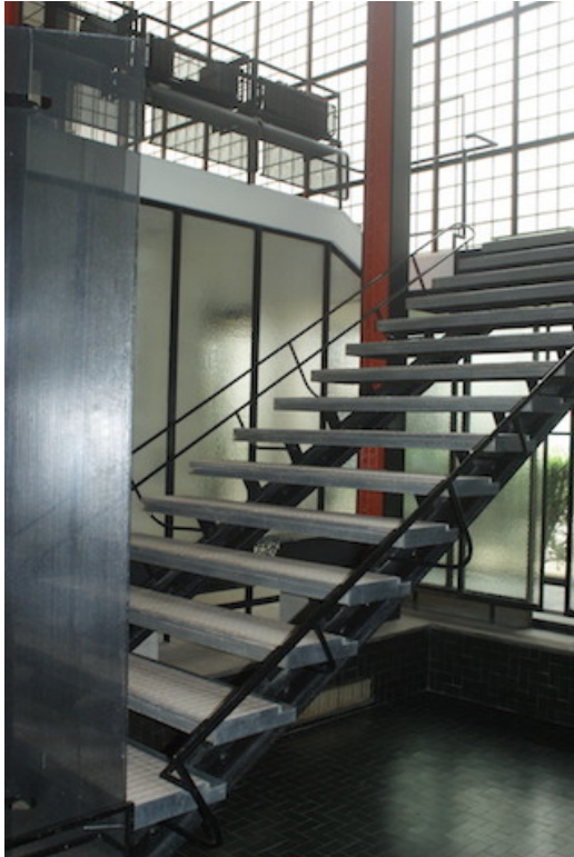
main staircase, Maison de verre, Paris, 1932 B. Bijvoet, P. Chareau, 1926-1932
